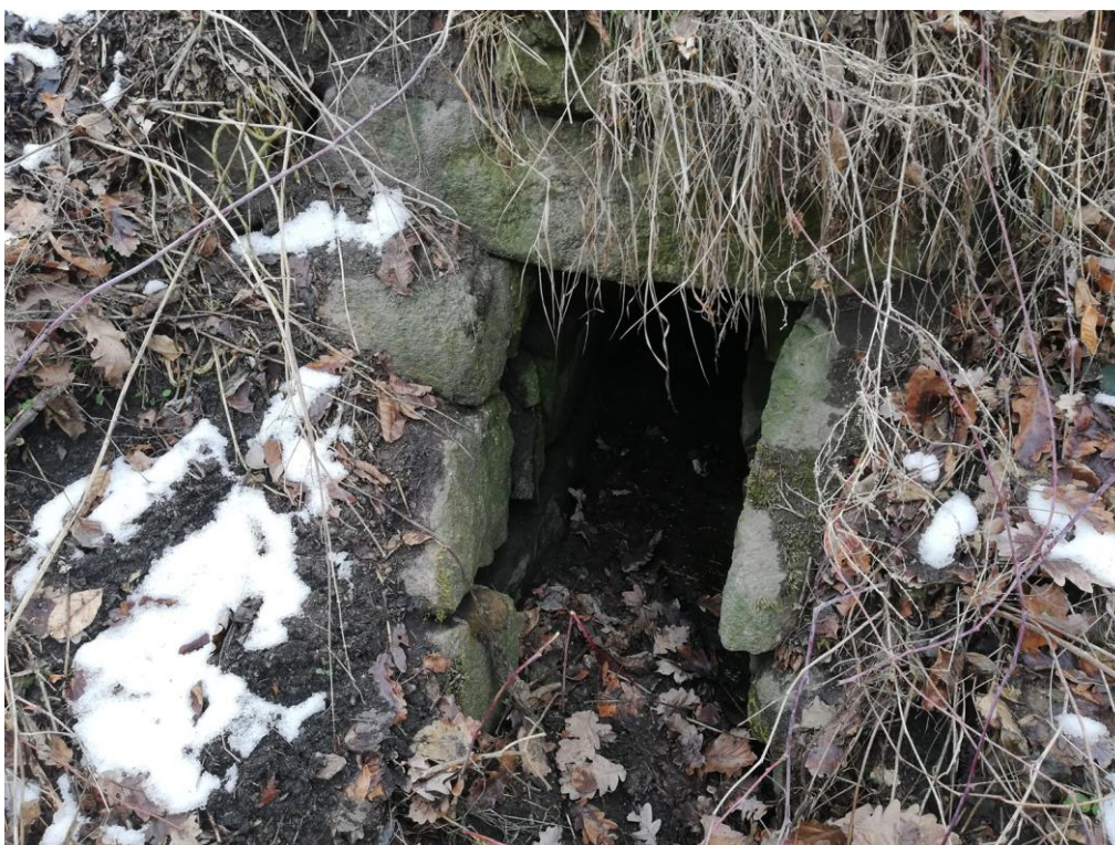
Foto č.4 - Pohled na výtokové čelo propustku.
